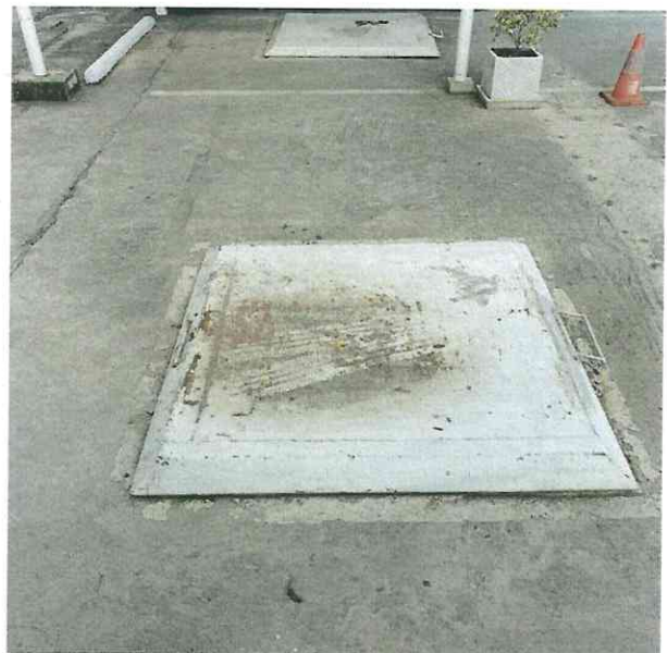
รูปที่ 47 โครงการออกแบบฝาดัง (ช่องคนเข้า) เพื่อให้เจ้าหน้าที่สามารถเข้าไปตรวจสอบ ซ่อมบำรุง จำนวน 2 ฝาดัง โดยตำแหน่งฝาดังอยู่บริเวณพื้นที่จอดรถ
