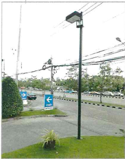
รูปที่ 21 โครงการมีการติดตั้งไฟฟ้าส่องสว่างบนถนนภายในโครงการ และบริเวณทางเข้า-ออกโครงการ ให้สามารถมองเห็นรถที่จะเข้าหรือออกจากโครงการได้อย่างชัดเจนในช่วงเวลากลางคืน
