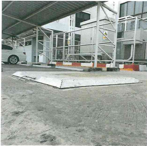
รูปที่ 47 โครงการออกแบบฝาดัง (ช่องคนเข้า) เพื่อให้เจ้าหน้าที่สามารถเข้าไปตรวจสอบ ซ่อมบำรุง จำนวน 2 ฝาดัง โดยตำแหน่งฝาดังอยู่บริเวณพื้นที่จอดรถ
