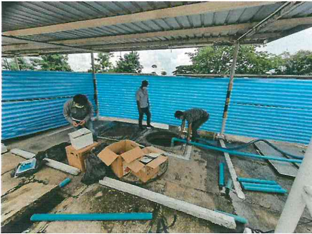
รูปที่ 46 โครงการกำหนดให้มีการล้างทำความสะอาด และตรวจสอบอุปกรณ์ในถังประปาใต้ดิน ทุก 6 เดือน
